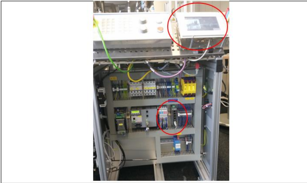
44. ábra: A hálózati összetevők felszerelése- HMI bekötése
